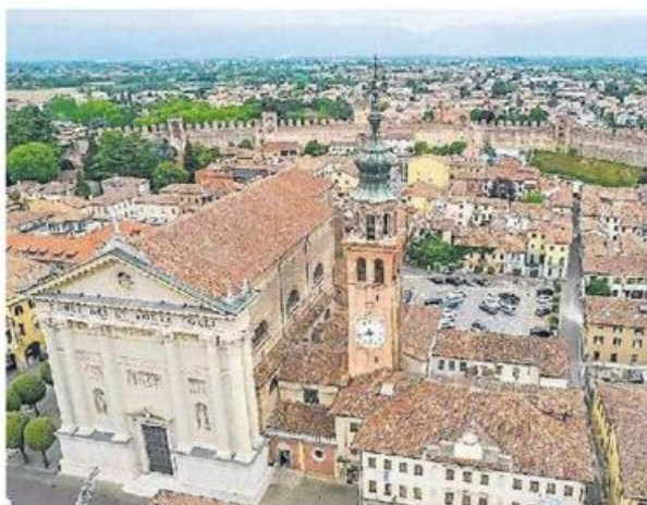
IL COMPLESSO Il Duomo di Cittadella è stato messo in sicurezza
